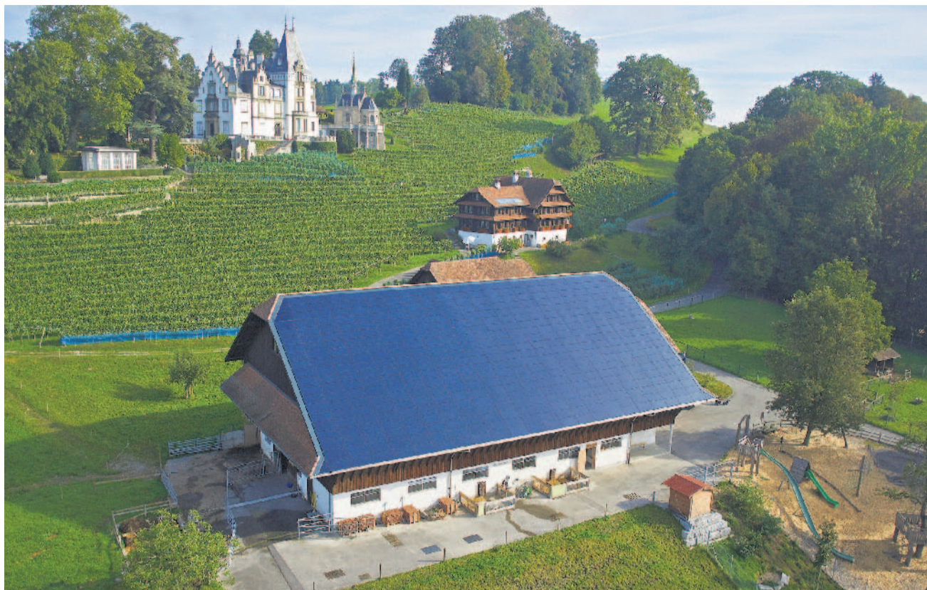
Die Gemeinde Meggen setzt auf erneuerbare Energien. Auf dem Dach der Scheune Meggenhorn wurde im Oktober 2013 eine Photovoltaikanlage in Betrieb genommen. Hochleistungsmodulare produzieren auf einer Fläche von 560 m 2 jährlich rund 90 000 kWh Solarstrom.
